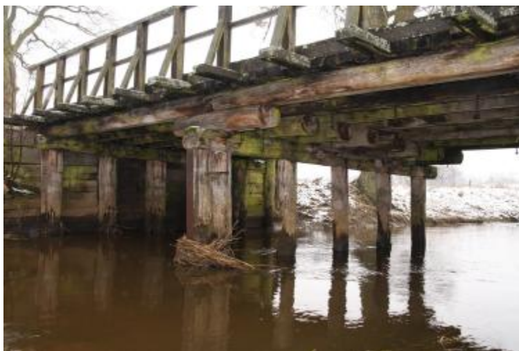
Fotografia 6 Widok spodu konstrukcji nośnej mostu
