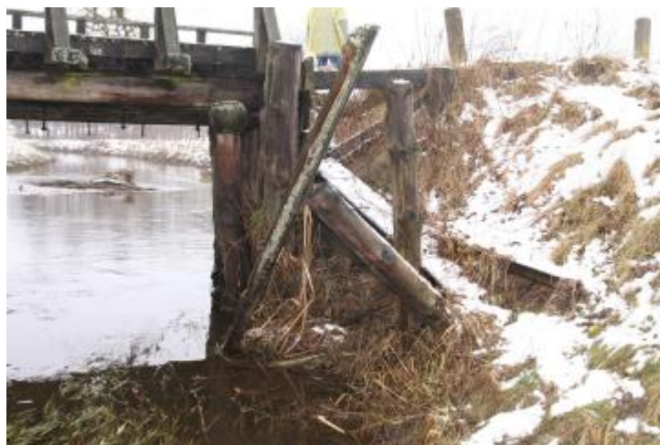
Fotografia 7 Zdewastowane skrzydło przyczółka od strony wsi Pluty
