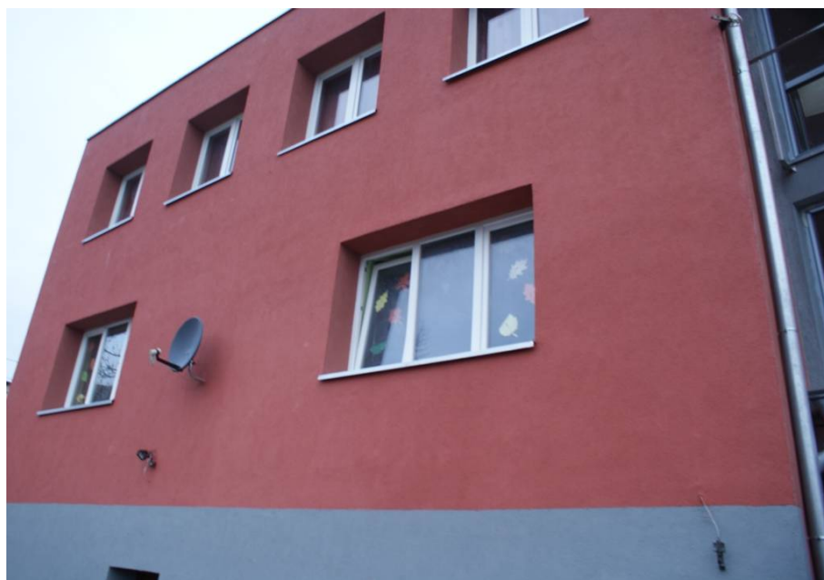
Elewacja MDK po remoncie
