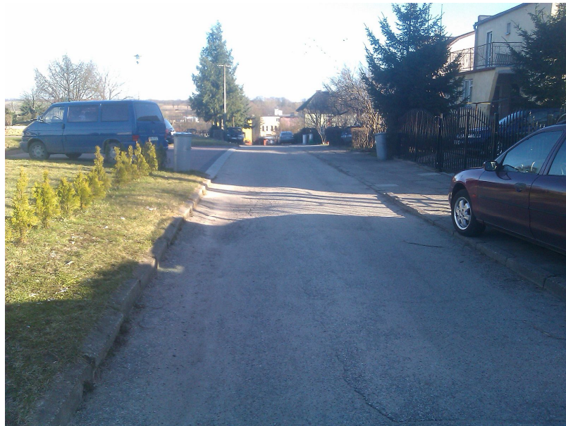
Fot. 2. Widok na przebudowywaną drogę w km 0+040.
