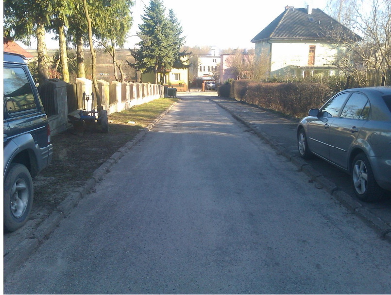
Fot. 3. Widok na przebudowywaną drogę w km 0+100.
