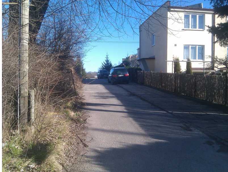
Fot. 1. Widok na przebudowywaną drogę w km 0+000.
