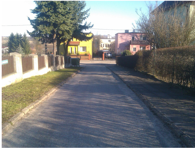
Fot. 4. Widok na przebudowywaną drogę w km 0+130.
