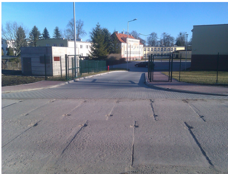
Fot. 3. Widok na istniejący zjazd w km 0+085,16.
