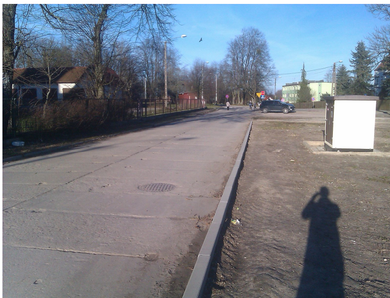
Fot. 4. Widok na przebudowywaną drogę w km 0+100.
