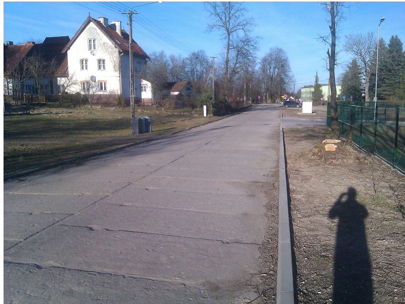
Fot. 2. Widok na przebudowywaną drogę w km 0+050.
