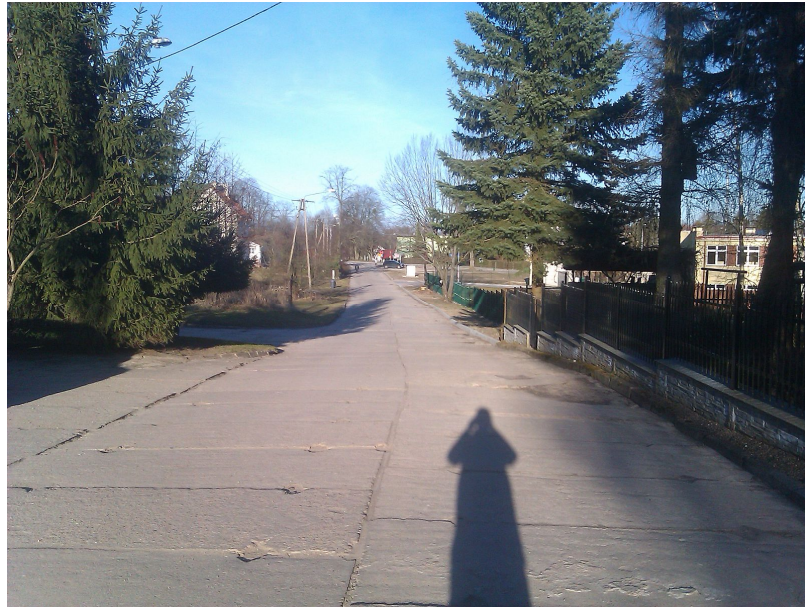
Fot. 1. Widok na przebudowywaną drogę w km 0+000.
