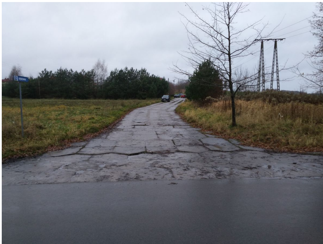
Fot. 7. Widok końca analizowanego ciągu ulic, tj. skrzyżowania ulicy Lipowej z ulicą Królewiecką – drogą powiatową nr 2376N.
