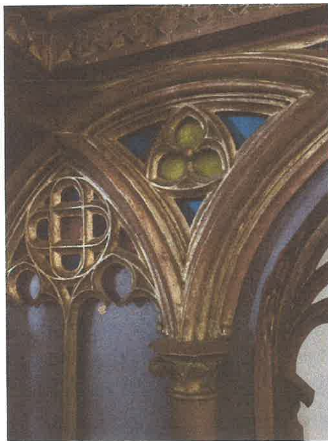
Fot. 11 Wtórne przezłocenia szlagmetalem i brązą detalu snycerskiego ołtarza
