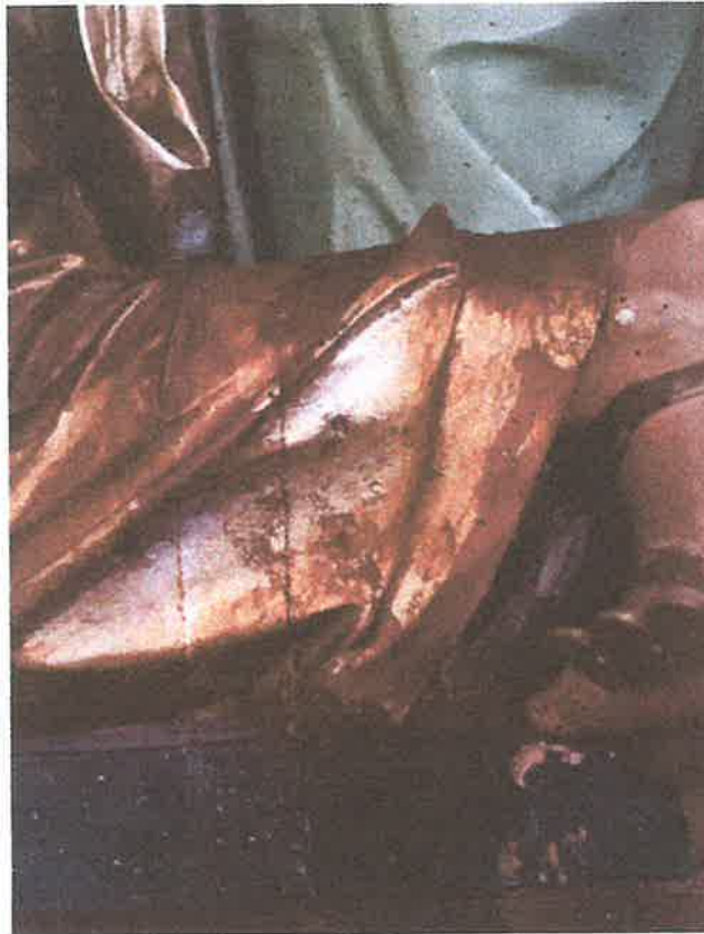
Fot. 8 Procesy korozyjne po użyciu niewłaściwych materiałów w obrębie figur
