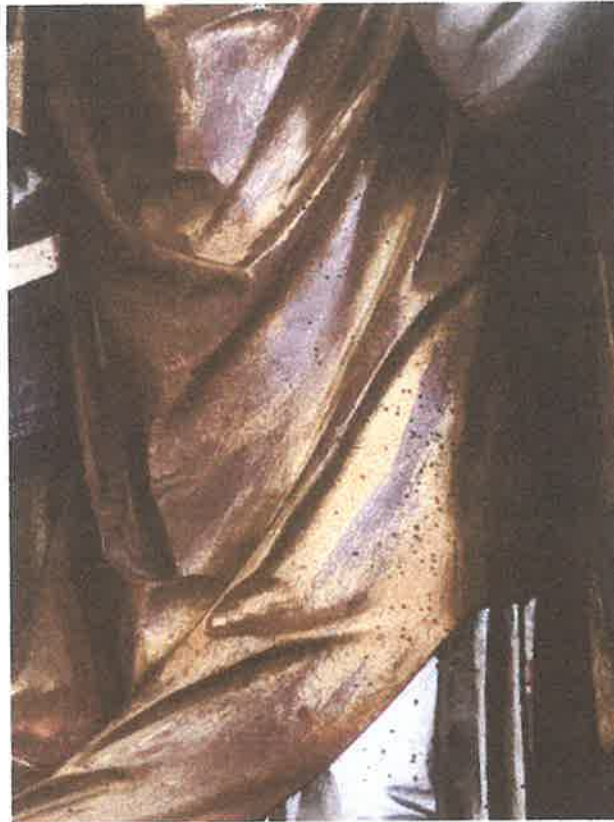
Fot. 10 Procesy korozyjne szlagmetal, wtórna warstwa pozłotnicza
